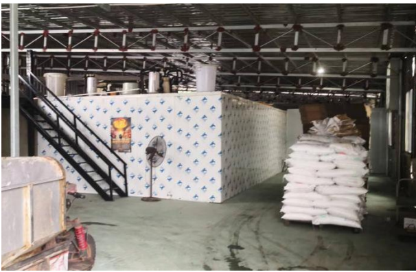
项目生产车间
