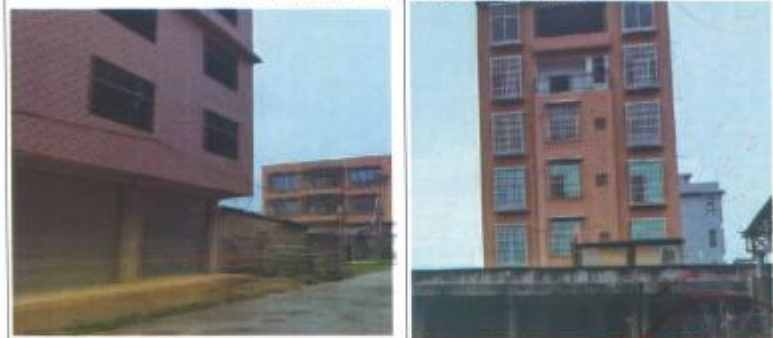
南面为隔道路空厂房和空地
